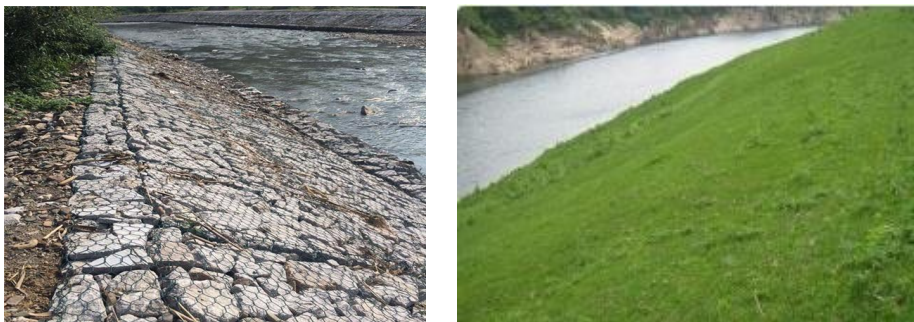
图 2-3 典型格宾石笼结合植物护坡效果图
